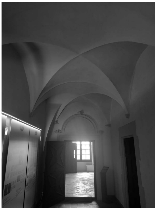
FIGURA 22. Monasterio de Pedralbes. Paso de comunicación entre la galería este del claustro alto y la celda de san Juan
