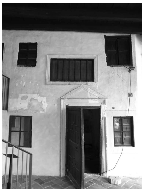
FIGURA 19. Monasterio de Pedralbes. Fachada de la celda de santa Marta
