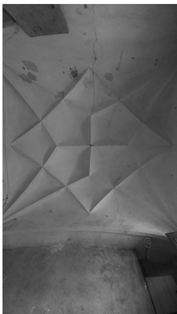
FIGURA 20. Monasterio de Pedralbes. Bóveda de la celda de la Soledad
