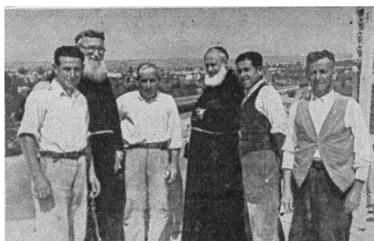
IMAGEN 13. El P. Estanislao de Guadasuar y el P. Gabriel de Priego, con los obreros, durante la construcción del colegio 79
